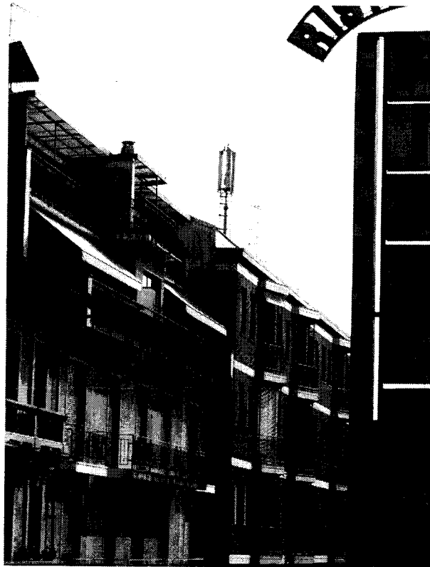
Foto 1: Impianto TIM via Mazzini 55
