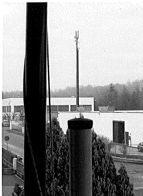
Foto 2: centralina di monitoraggio
