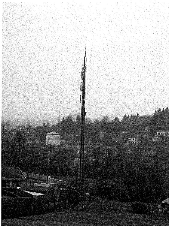
Foto 1: Impianti C/o Cimitero
