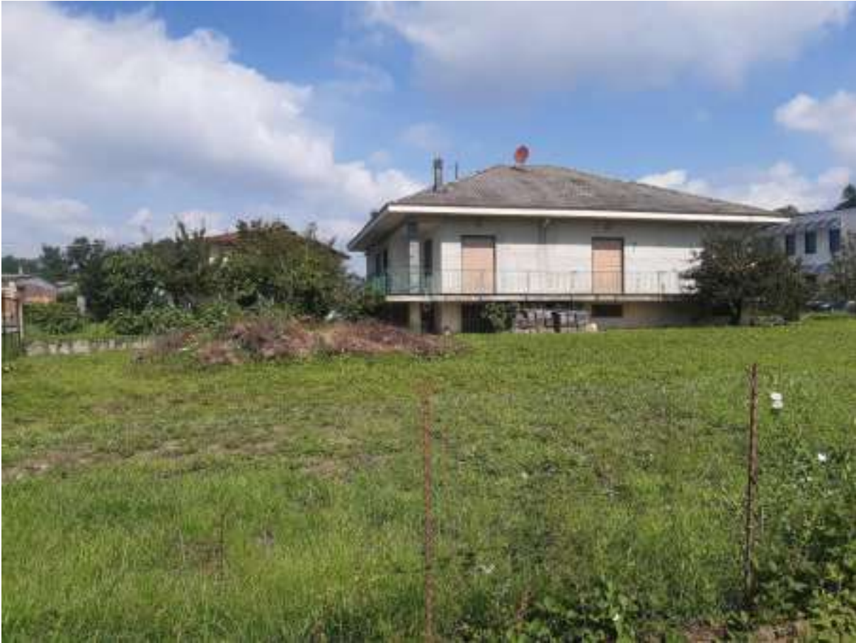
VISTA SECONDO FABBRICATO RESIDENZIALE
