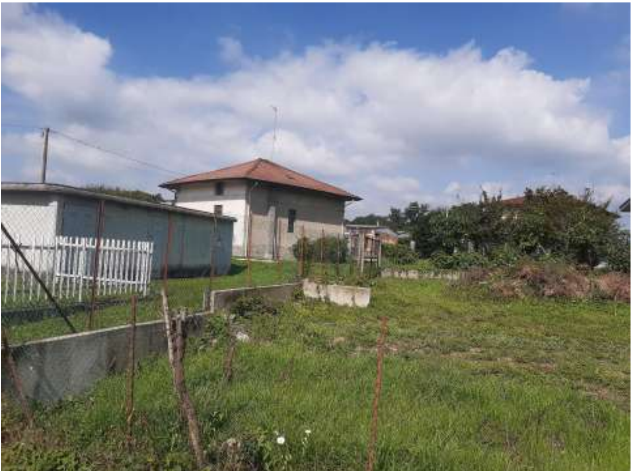
VISTA PRIMO FABBRICATO RESIDENZIALE
