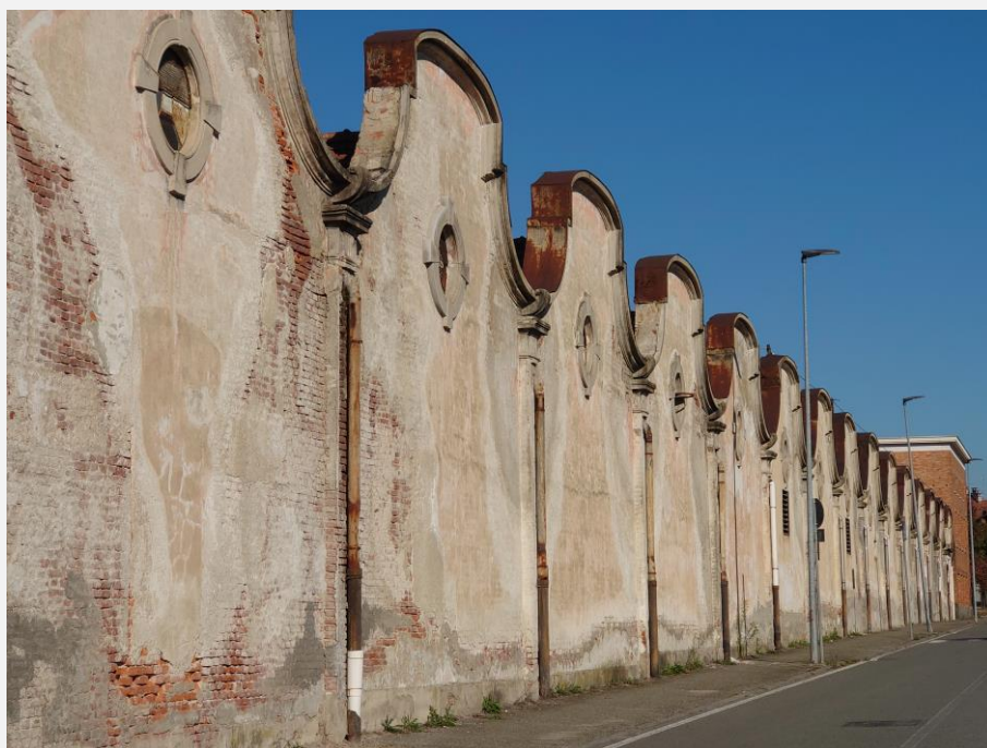
Figura 2.4 – Edificio storico industriale
