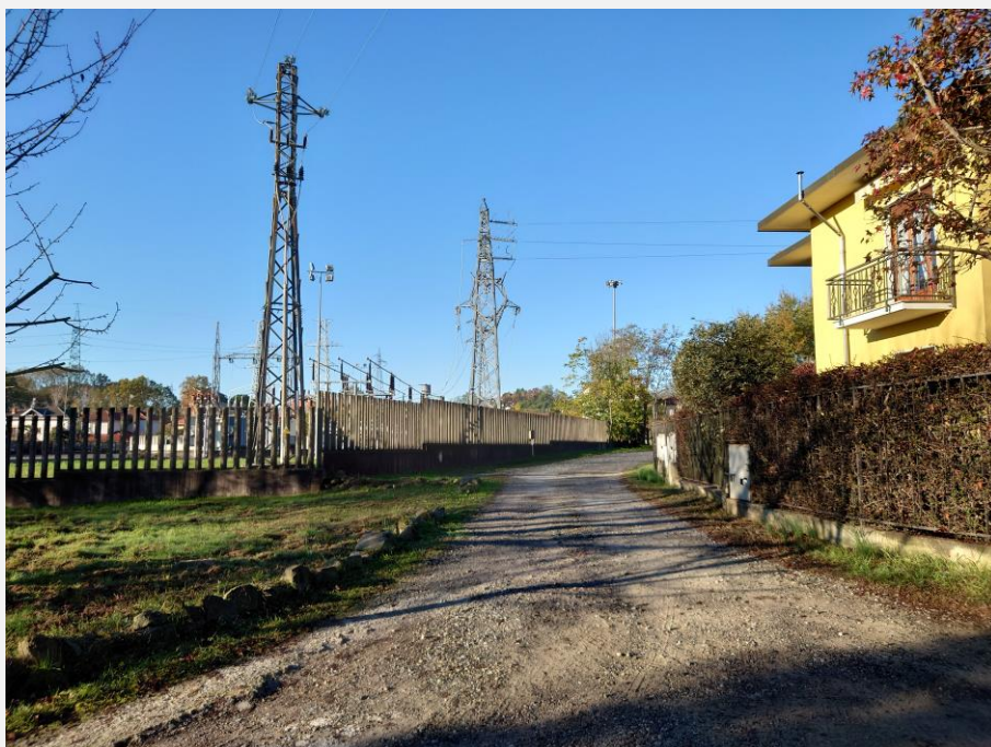
Aree residenziali e sottostazione elettrica Via Maffei
