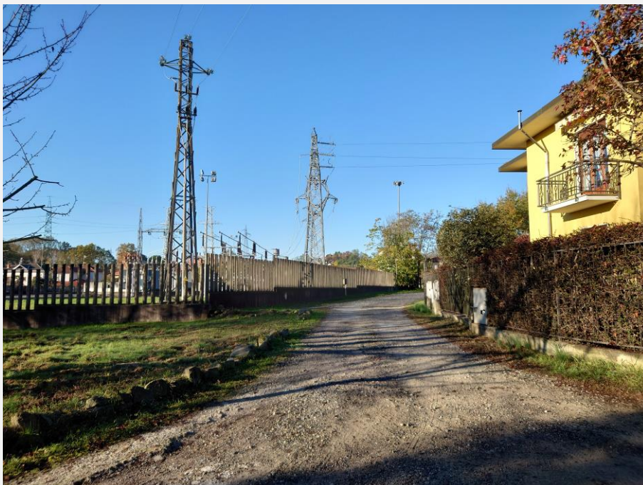
Aree residenziali e sottostazione elettrica Via Maffei
