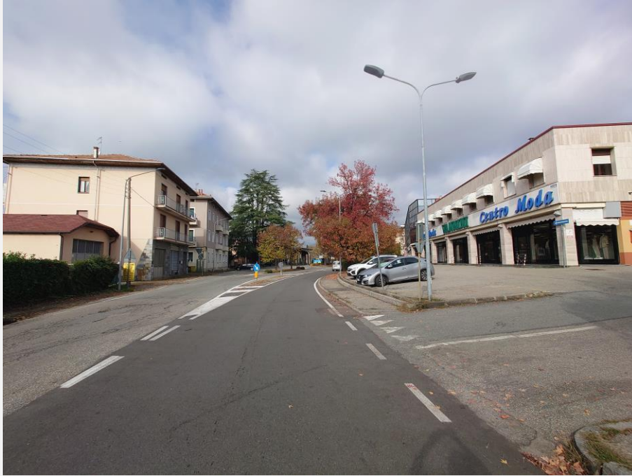
Aree residenziali e stazione ferroviaria Via Pajetta
